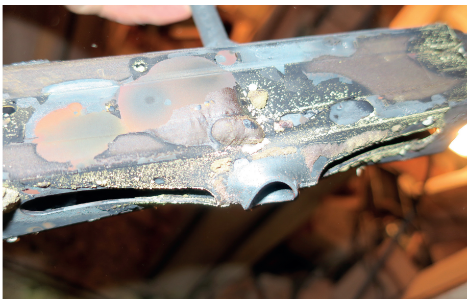
Abbildung 4: Deformierte Rückenlochung einer Montageschiene nach Brandversuch
