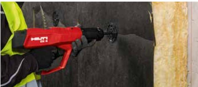
Wärmedämmung bis 200 mm kann in Beton einfach und effizient mittels Direktmontage befestigt werden. Die Kombination aus dem Bolzensetzgerät und den Dämmstoffbefestigern X-IE setzt Massstäbe in punkto Sicherheit und Geschwindigkeit. Natürlich bieten wir Ihnen auch die passende Dübel- oder Schraublösung zur Dämmstoffbefestigung für alle Untergründe an.
