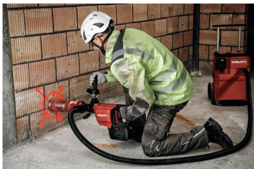
Bild 1: Handgeführte Trockenbohrung im Mauerwerk mit dem Nuron Akku-Kernbohrgerät DD 150-U-22 mit der SPX A Speed Bohrkronen und angeschlossenem Akku-Sauger VC 4X-22.
