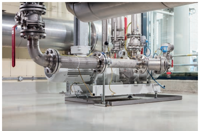
Bild 5 Befestigung von Dosier- und Fördereinheiten an Reaktoren
