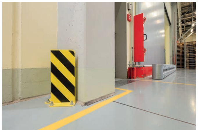
Bild 4 Befestigung von Anprallschutz und Absperrvorrichtungen auf Verkehrswegen zur Beförderung von wassergefährdenden Substanzen
