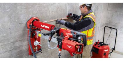
Gleichzeitig kommuniziert das Gerät mit dem Wassermanagementsystem per Bluetooth. Und während die Maschine noch die Bohrung zu Ende bringt, kann bereits die nächste Bohrung angezeichnet oder ein Dübel gesetzt werden. Arbeiten Sie deutlich produktiver dank semiautomatischer Bohrtechnik.
