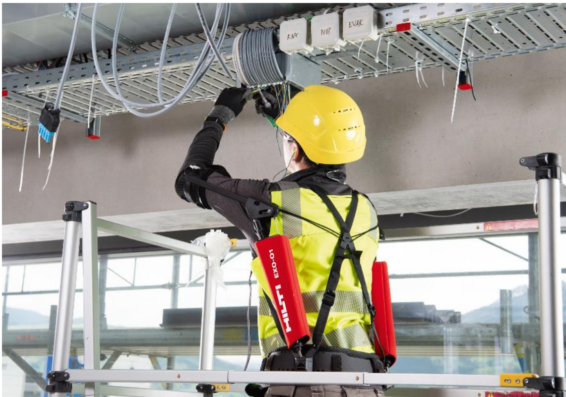
Anwendungsbeispiel: Das Hilti EXO-O1 entlastet den Anwender bei seriellen Schraubarbeiten, die über der Schulter oder über dem Kopf ausgeführt werden müssen.
