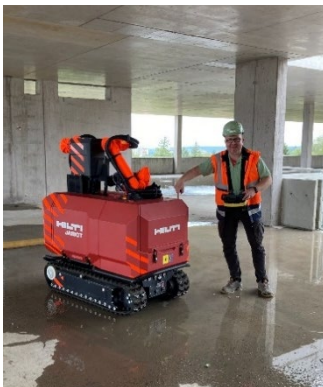
Bild 1: Markus Voigt, Senior Projektmanager bei Geiger Schlüsselfertigbau GmbH & Co. KG, mit dem Jaibot im Einsatz bei dem Bürogebäudebau Welle 2 in Reutlingen.
