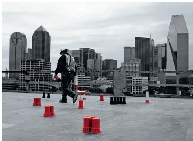
**Bild 1.** Brandschutz als Einlegebauteil
