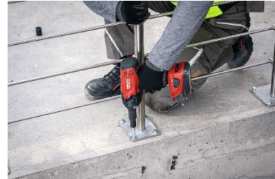
b) Befestigung von Handläufen
