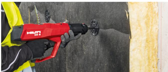
Wärmedämmung bis 200 mm kann in Beton einfach und effizient durch Direktmontage befestigt werden. Die Kombination aus dem Bolzensetzgerät DX 6, das auch zur Montage der Konsolen eingesetzt werden kann, und den Dämmstoffbefestigern X-IE setzt Massstäbe in punkto Sicherheit und Geschwindigkeit. Alternativ kann mit dem Dämmstoffbefestiger HIF auch klassisch gedübelt werden.
