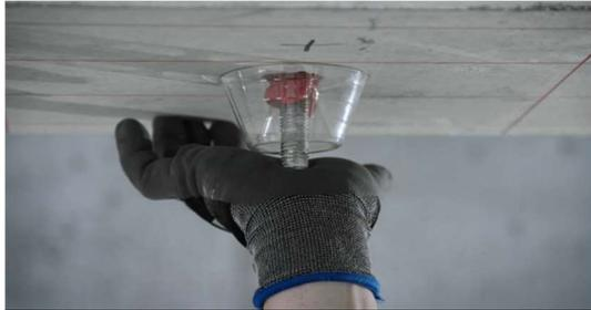
**Schritt 11:** Einschieben der Gewindestange bis zum Bohrlochgrund mit anschließender optischer Kontrolle, ob eine ausreichende Mörtelmenge durch Austritt am Bohrlochmund erkennbar ist.
