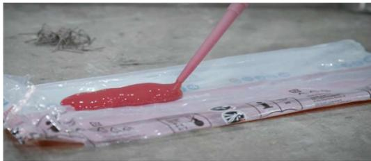
**Schritt 9:** Verwurf der ersten Hübe nach Vorgabe der Installationsanleitung zur Sicherstellung der ordnungsgemäßen Durchmischung von Harz und Härter.
