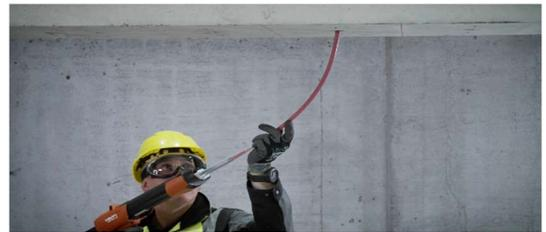
**Schritt 10:** Injektion des Bohrlochs vom Bohrlochgrund aus innerhalb der Verarbeitungszeit mit geeignetem Zubehör zur Sicherstellung einer blasenfreien Verfüllung und ausreichenden Mörtelmenge.
