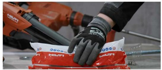
**Schritt 8:** Vorbereitung des spezifizierten Injektionssystems einschließlich sämtlichen erforderlichen Zubehörs.
