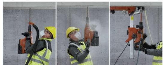
Schritt 4: Die Bohrlocherstellung ist gemäß der Spezifikation und Detailplanung mit dem jeweils festgelegten Bohrverfahren (Hohlbohrer, Hammerbohrer oder Diamantbohrer) an der Bohrposition bis zur Tiefe  $l_{sw}$  durchzuführen.
