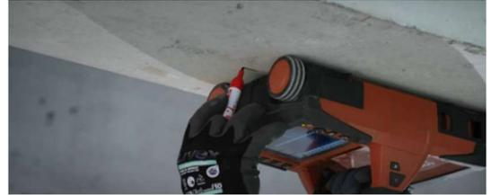
Schritt 1: Lokalisation und Kennzeichnung vorhandener Bewehrungsstäbe, Bügel sowie weiterer Einbauten auf der Betonoberfläche gemäß Spezifikation
