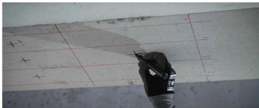
Schritt 2: Schritt 2: Anzeichnen der Bohrposition auf der Betonoberfläche entsprechend der Spezifikation oder Detailplanung
