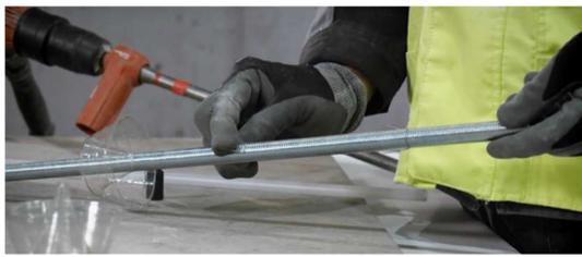
**Schritt 7:** Vorbereitung der Gewindestange zur Positionierung und Arretierung im Bohrloch.
