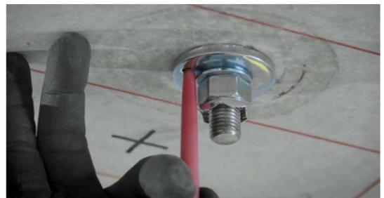
**Schritt 16:** Verfüllung der Hilti Dichtscheibe mit geeignetem Hilti Injektionsmörtel durch 1–3 Hübe, entsprechend der Vorgaben in der Installationsanleitung.
