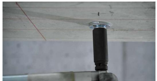
**Schritt 14:** Installation des Hilti Verfüllsets manuell oder mit dem SI-AT-22 Adaptiven Drehmomentmodul unter Beachtung aller Komponenten und des maximalen Drehmoments.
