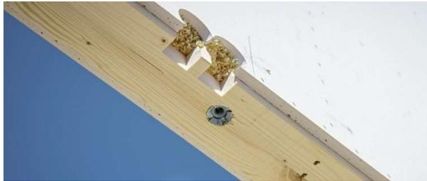
Hilti HCW Holzverbinder ermöglichen eine schnelle und effiziente Montage von vorgefertigten Holzelementen.
