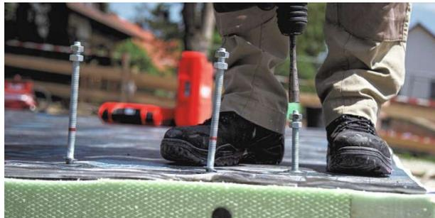
Die HCW und HCW-L verfügen über einen integrierten Klemmmechanismus für eine einfache Push-to-Fit-Montage mit Hilti Dübelssystemen.
